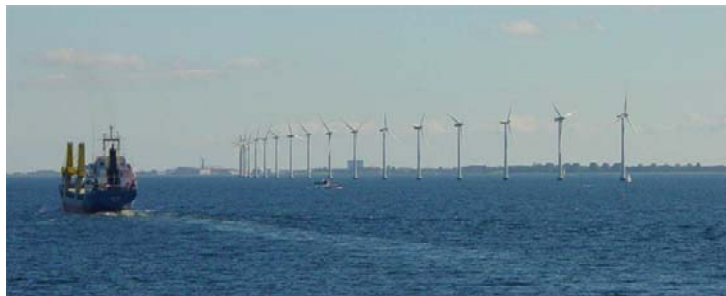
圖七、丹麥5600 風能發電機供應國內20% 能量，還有部分電力賣給德國，且創造新產業，生產風能發電機90% 外銷。
