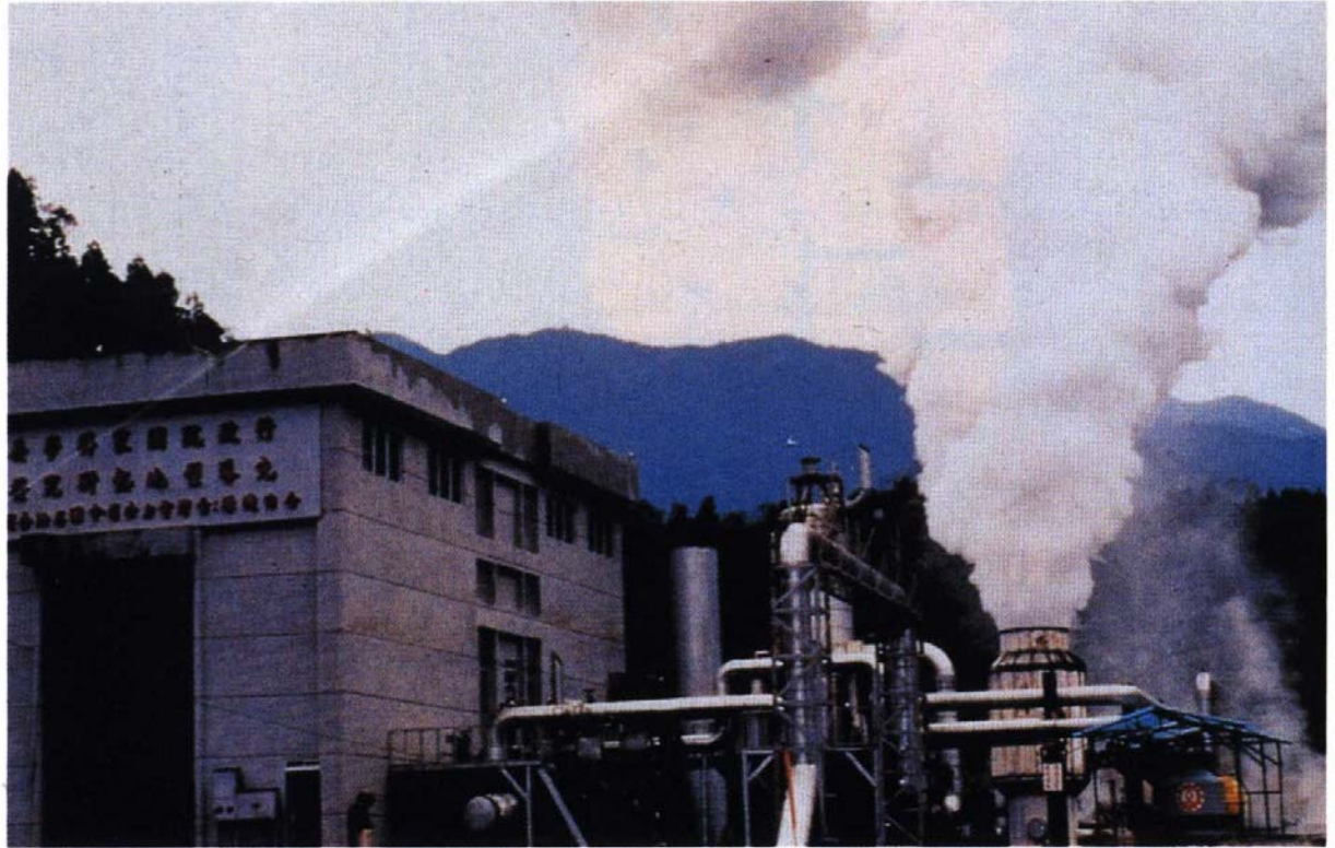
■ 台電公司三千瓩清水地熱試驗電廠
